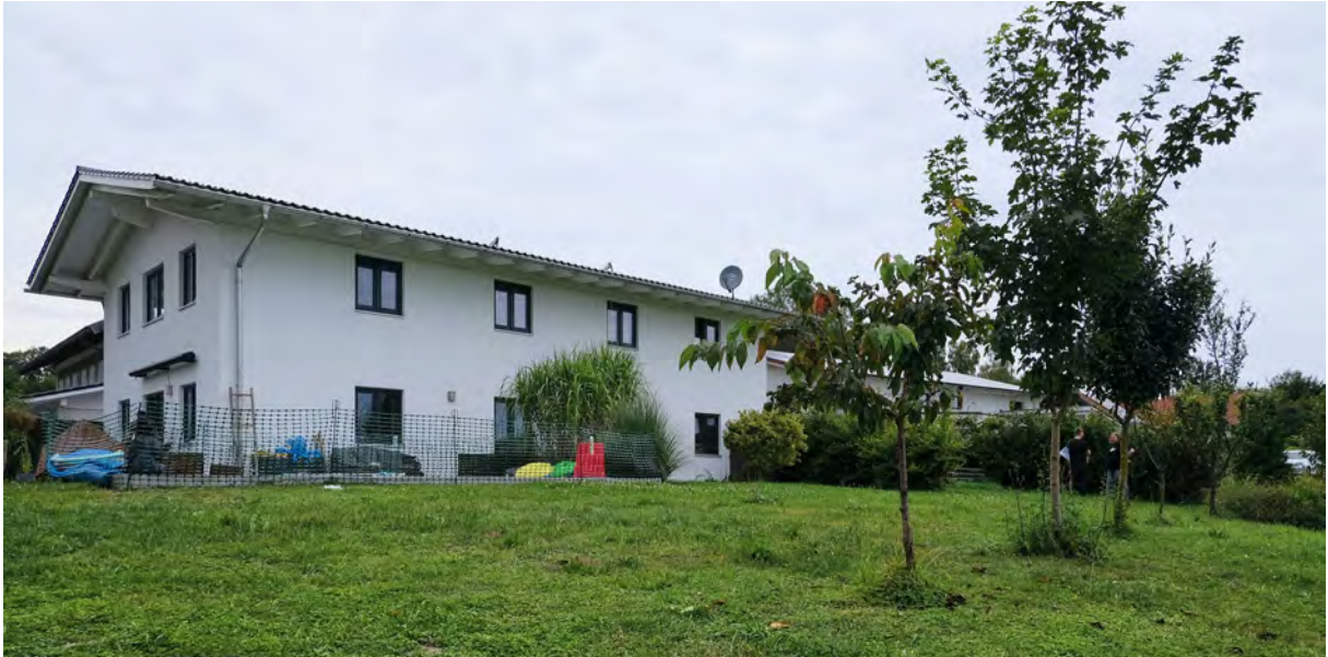
Abbildung 2: Blick von Südosten auf die einzubeziehende Fläche vor dem bestehenden Wohnhaus
